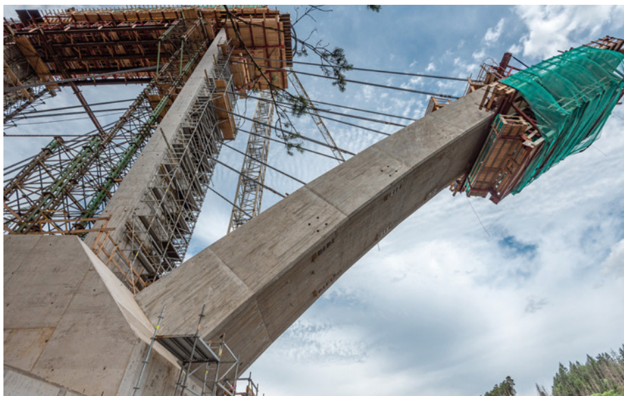
Obr. 11 Betonáž oblouku technologií letmé betonáže s postupným vyvšováním
