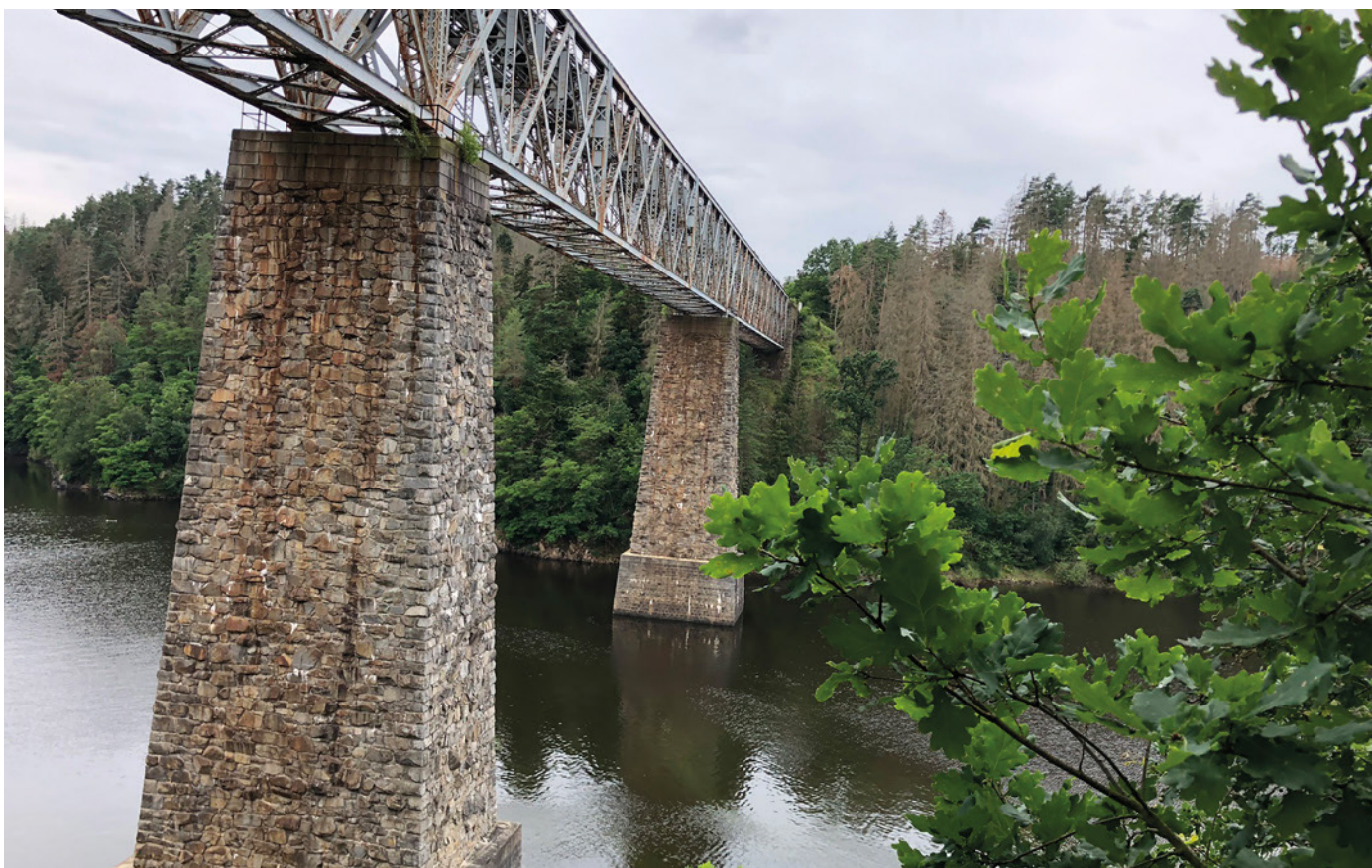
Obr. 1 Stávající ocelový železniční most u Červené nad Vltavou
