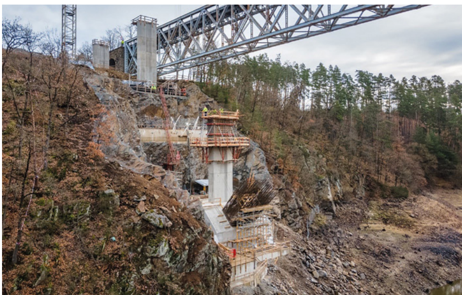
Obr. 8 Pata oblouku na pravém břehu
