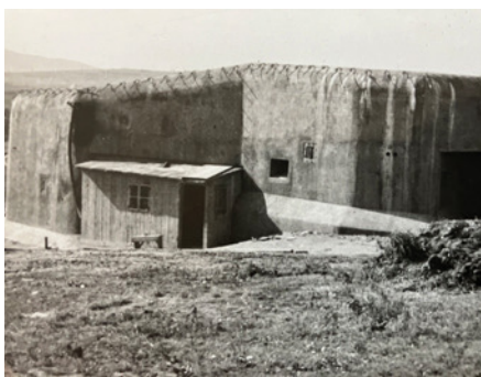
Obr. 9 Stavebně dokončovaný objekt těžkého opevnění, foto: archiv autora, 1937
