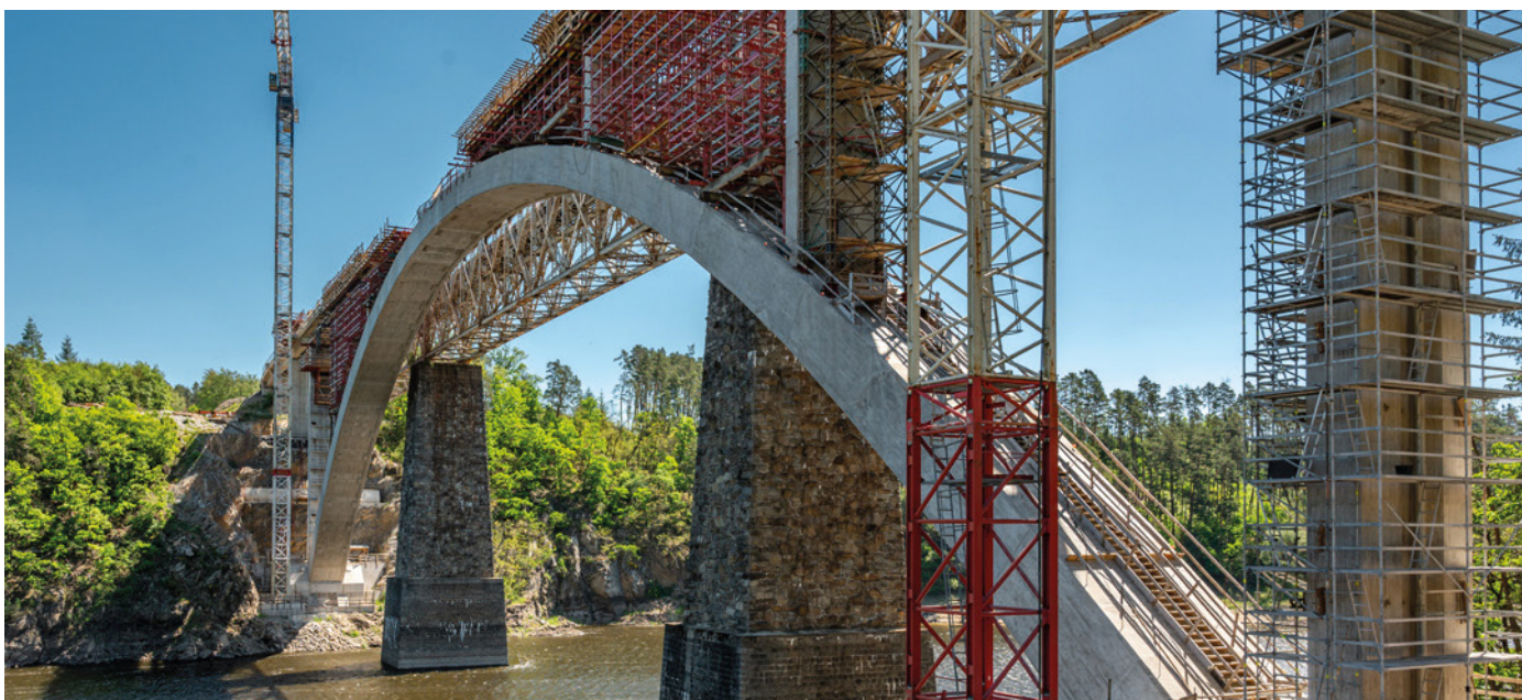
Obr. 13 Montáž pevné skruže na oblouku
