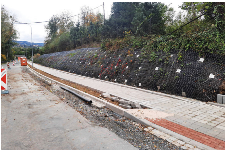
Obr. 6 Lubno 2024, zářezový svah stabilizovaný přiklepem hnanými zemními kotvami
