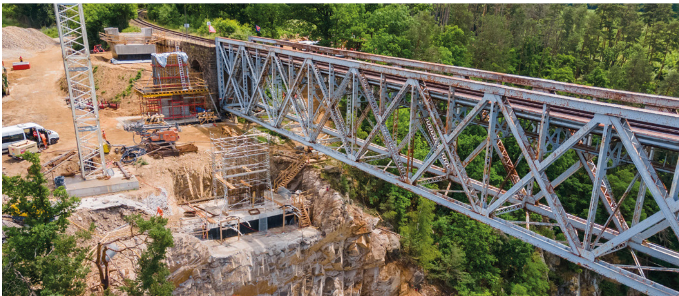
Obr. 7 Stavební práce na pravém břehu
