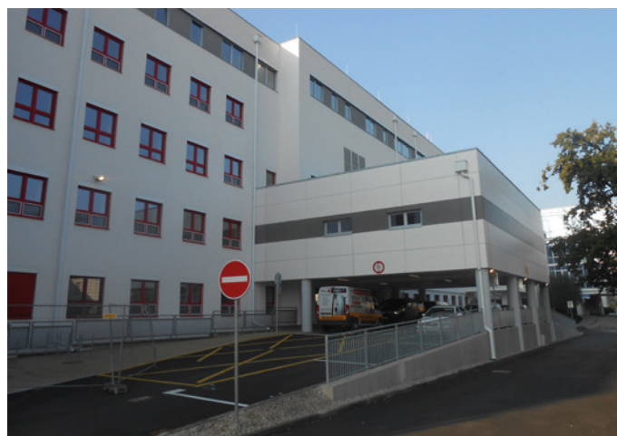
Obr. 2 Pavilon CH – severovýchodní pohled
