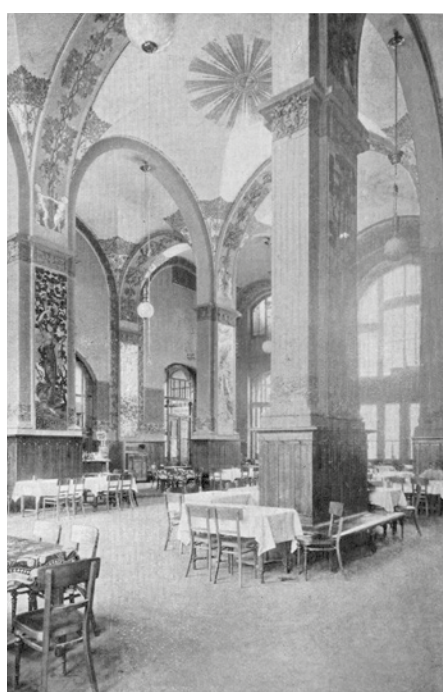
Obr. 7 Malý (sloupový sál) dobová fotografie (zdroj: Jan Vilím, Zlatá Praha, 1904)
