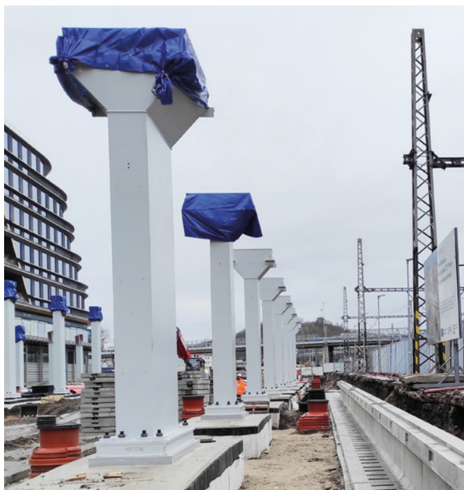
Obr. 5 Ocelový stĺp – Typ II, realizácia (zdroj: STRABAG Rail a.s.)
