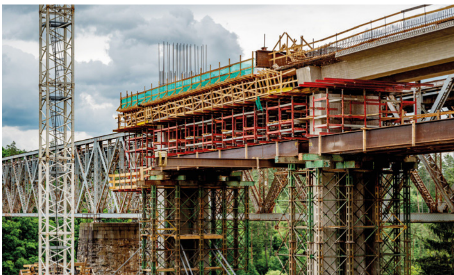
Obr. 9 Pevná skruž z těžké podpůrné konstrukce PÍŽMO a HEB nosníků
