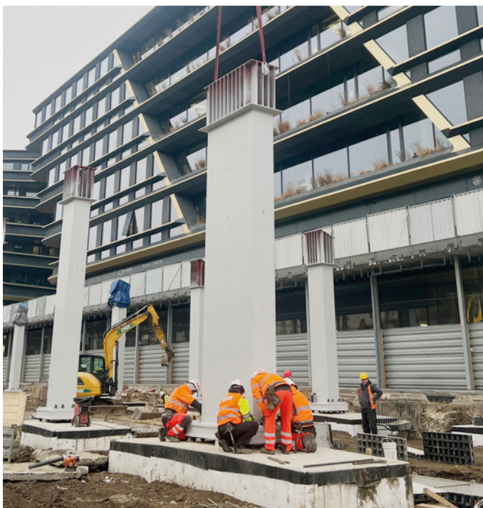
Obr. 4 Ocelový stĺp – Typ I, realizácia (zdroj: STRABAG Rail a.s.)
