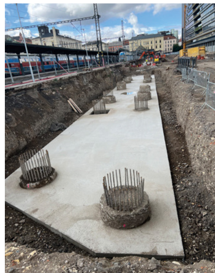
Obr. 11 Usporiadanie pilót základovej dosky, realizácia (zdroj: STRABAG Rail a.s.)
