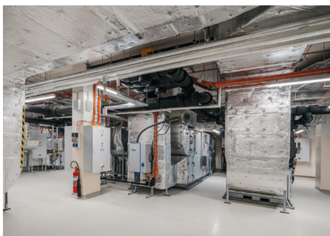
Obr. 6 Strojovna VZT ve 4. NP
