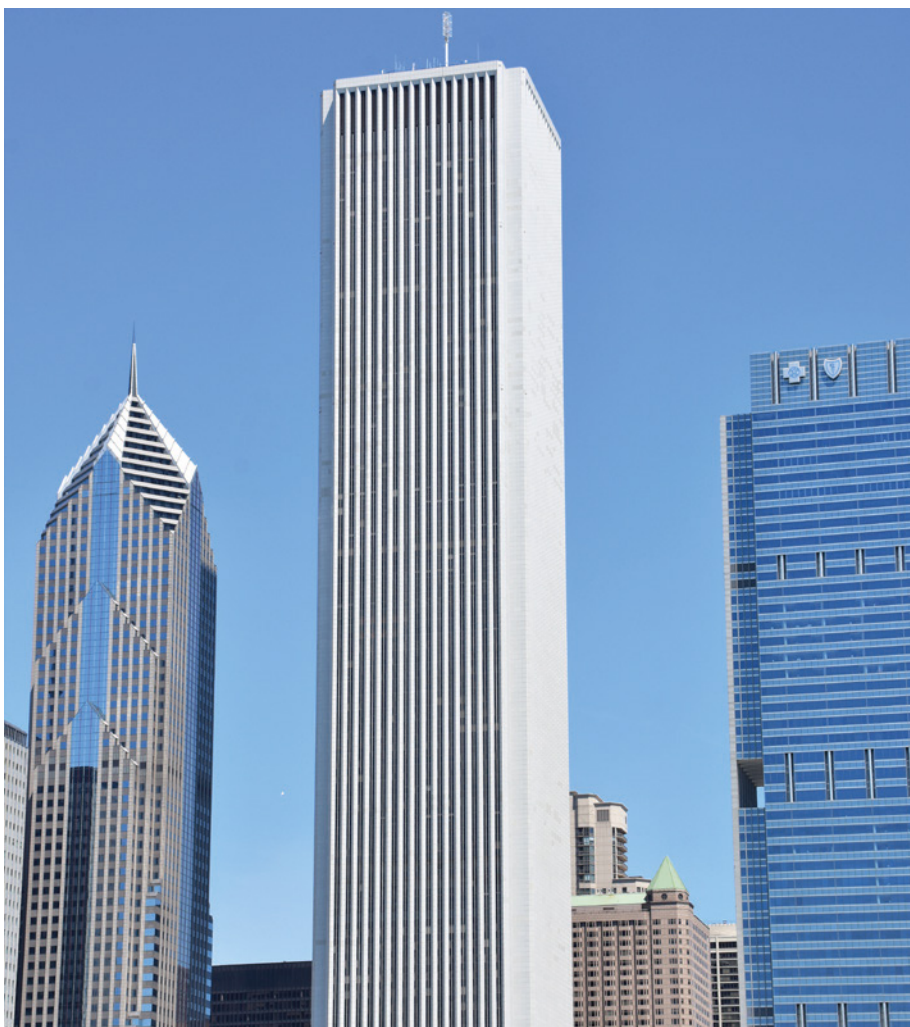
Obr. 5 Budova Aon Centra v Chicagu [zdroj: https://cs.wikipedia.org/wiki/Aon_Center_(Chicago) ]
