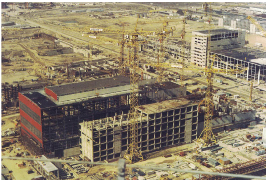
Obr. 2 Pohled na Jadernou elektrárnu Temelín v průběhu výstavby
