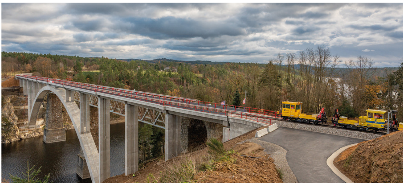
Obr. 15 Pokládání a úprava železničního svršku
