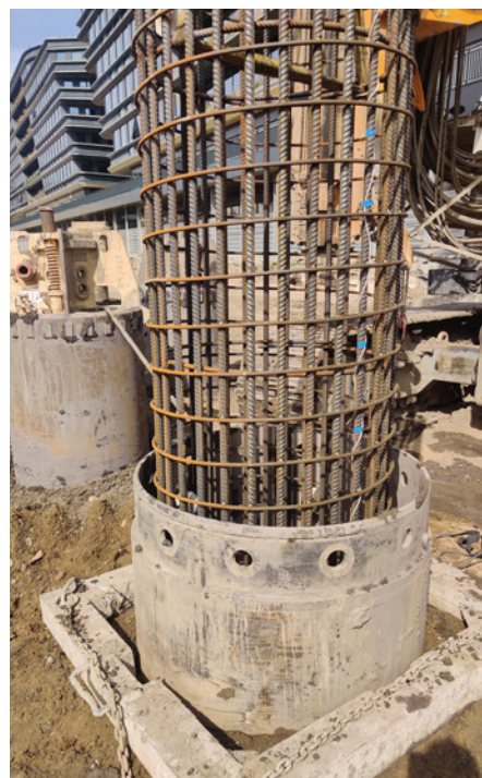
Obr. 9 Výstroj pilóty, realizácia (zdroj: STRABAG Rail a.s.)
