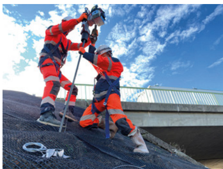
Obr. 4 Instalace přiklepem – manuální, strojní
