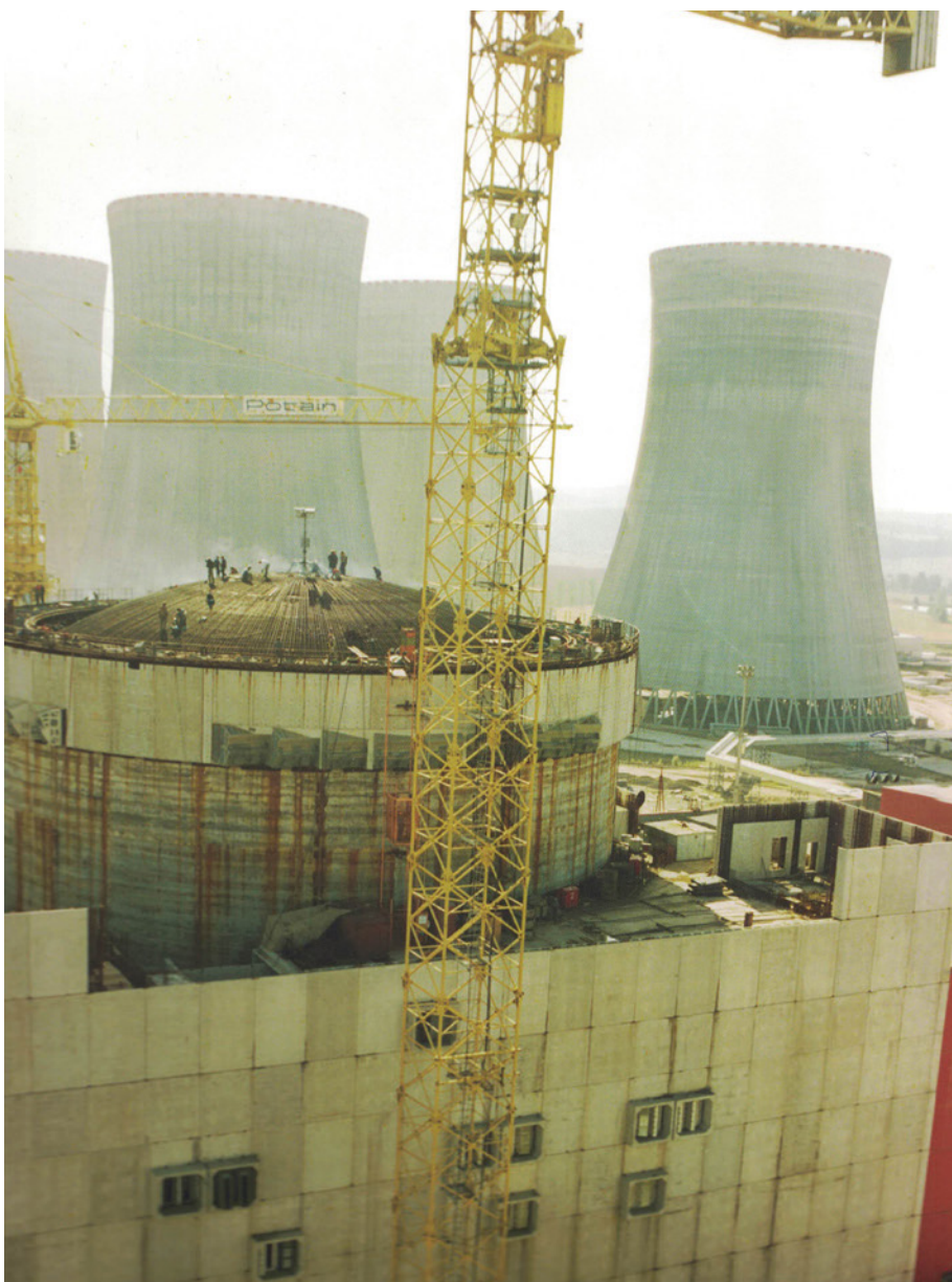
Obr. 6 Práce na kopuli reaktorovny
