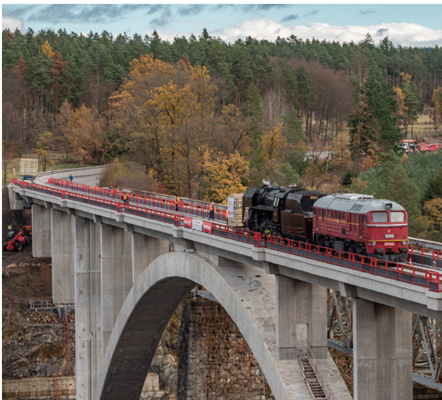
Obr. 14 Statická zatěžovací zkouška
