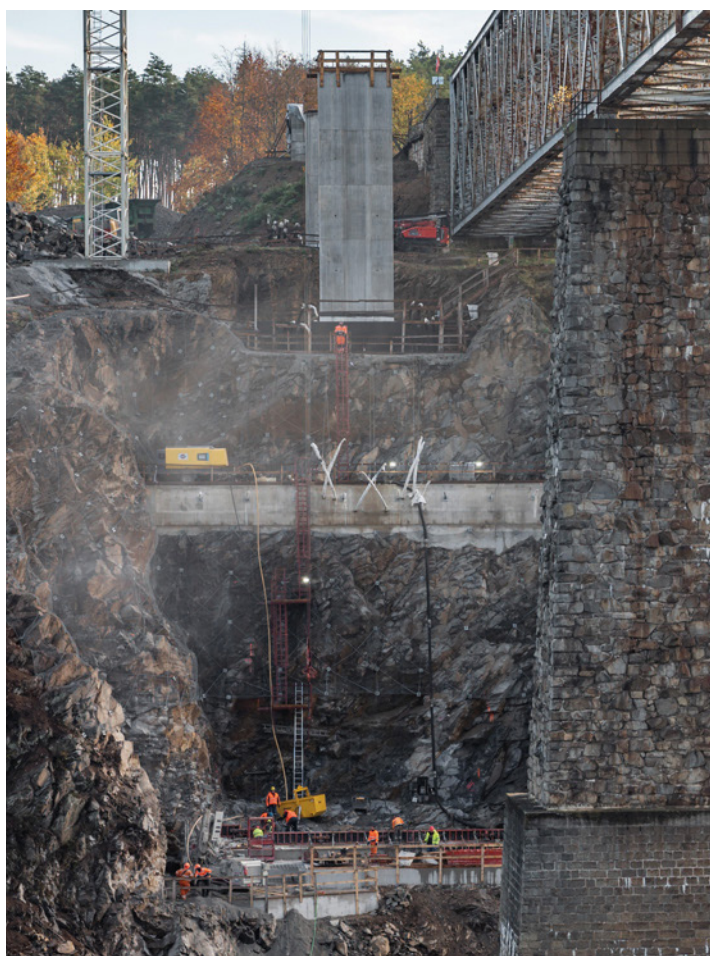
Obr. 6 Výkop pro pravobřežní základ oblouku. Uprostřed je kotevní blok dočasných montážních táhel, v pozadí jsou již vybetonované pilíře P1 a P2
