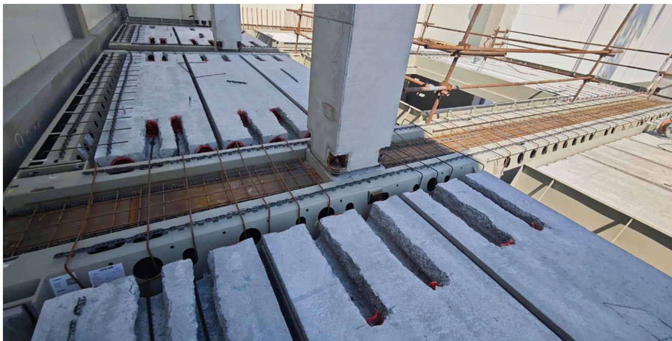
Obr. 3 Pohled na styk sloupů a nosníků v příčném rámu během realizace
