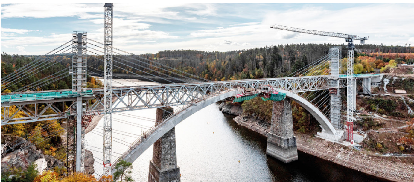
Obr. 10 Postupné vyvšování oblouku přes provizorní železobetonové pylony
