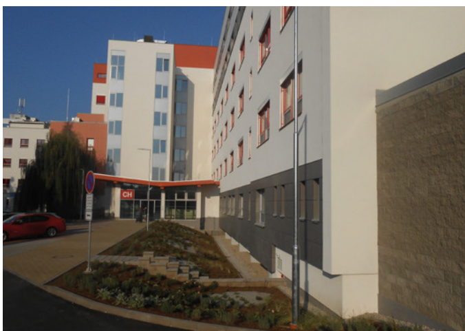
Obr. 1 Recepte pavilonu CH – východní pohled
