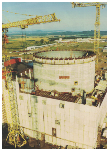
Obr. 3 Práce na kontejntu budovy reaktoru
