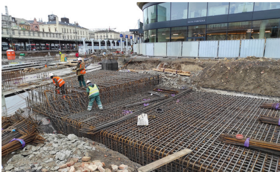
Obr. 10 Základová doska, realizácia (zdroj: STRABAG Rail a.s.)
