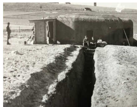
Obr. 10 Pěchotní srub po dokončení betonáže, foto: archiv autora, 1937
