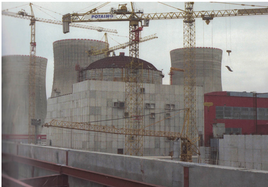
Obr. 5 Reaktorovna v průběhu výstavby
