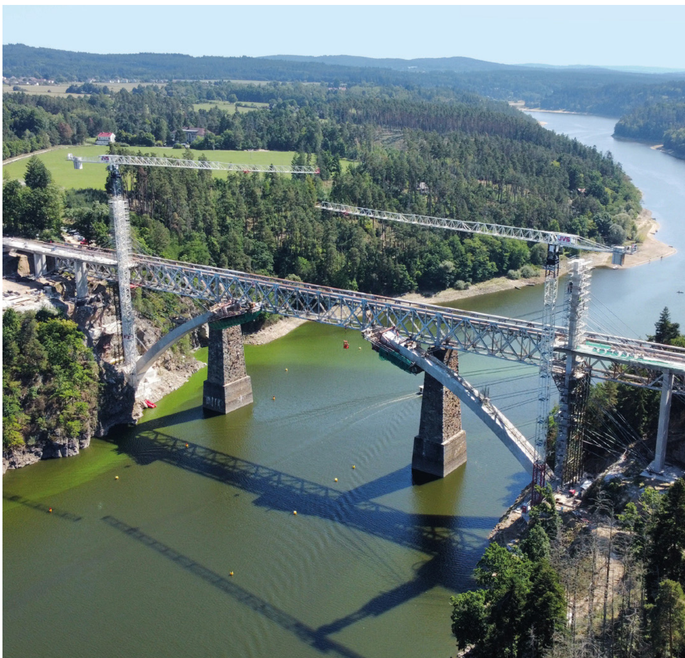
Obr. 2 Pohled na výstavbu nového jednokolejného železničního mostu s železobetonovým obloukem
