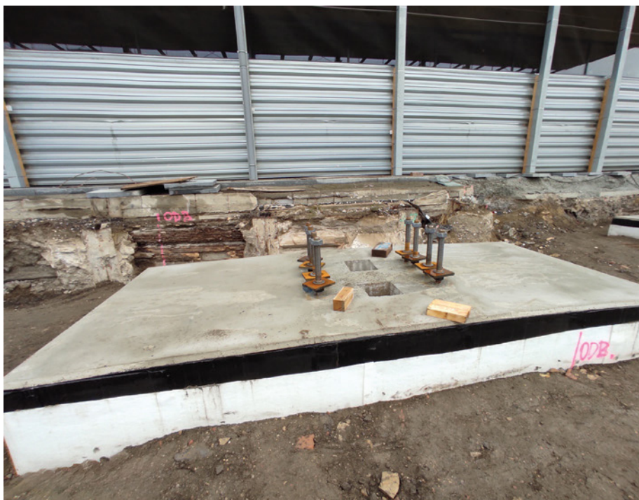
Obr. 8 Základová päťka, realizácia (zdroj: STRABAG Rail a.s.)
