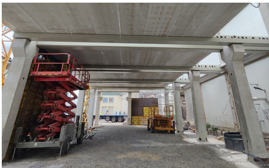
Obr. 4 Pohled na spřažený ocelobetonový nosník jednostranně vykonzolovaný k původní budově ve stropě nad 1. NP během pokládky předpjatých dutinových panelů
