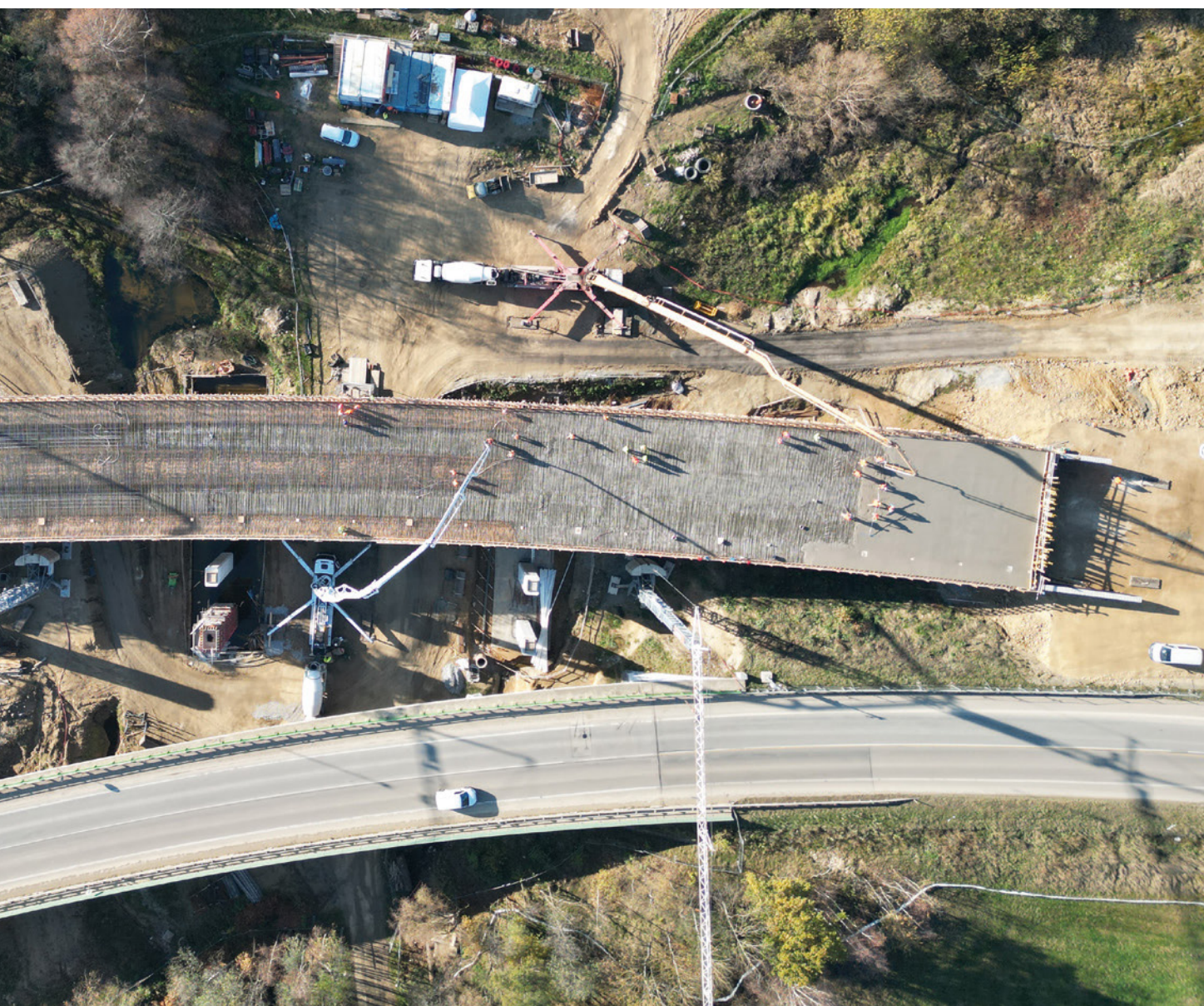
Obr. 2 Betonáž nosné konstrukce SO 217, při níž bylo uloženo více než 1 800 m 3 betonu.
