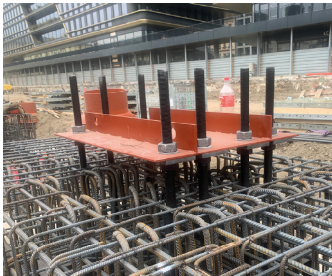
Obr. 7 Kotevný prípravok zabudovaný v základe (zdroj: STRABAG Rail a.s.)
