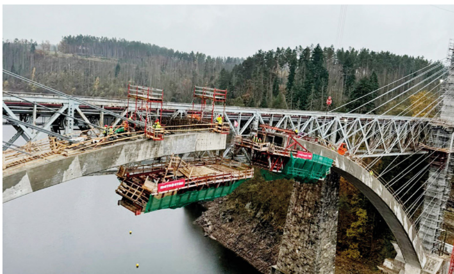
Obr. 12 Spouštění betonářských vozíků
