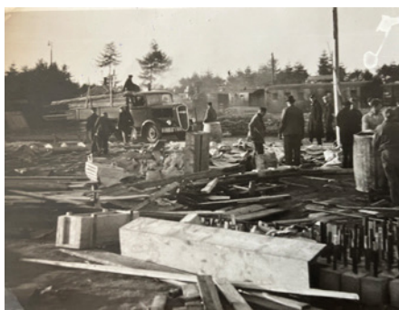
Obr. 8 Staveniště těžkého opevnění, foto: archiv autora, 1937
