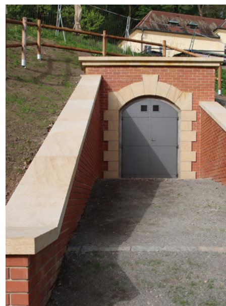
Obr. 20 Nový vstupní portál do štolý č. XXI na svahu Petřína
