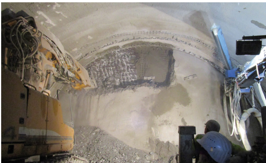
Obr. 10b Otevírání a zajišťování čelby po částech při zhoršení horninového prostředí (severní trouba)
