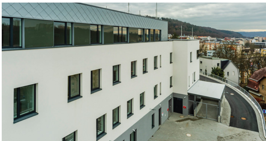
Obr. 2 Pohled na zrekonstruovanou budovu ze severovýchodu
