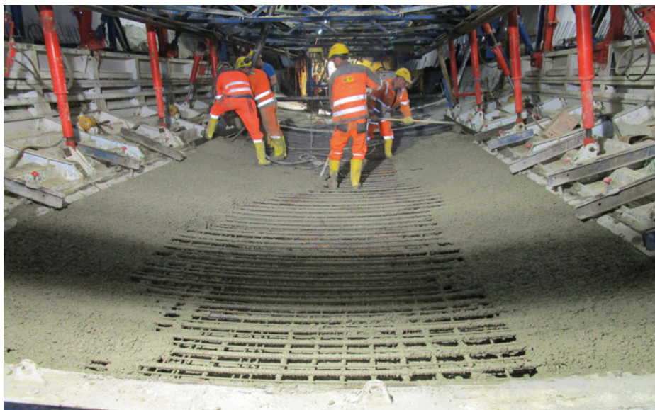
Obr. 18a Forma pro betonáž protiklenby
