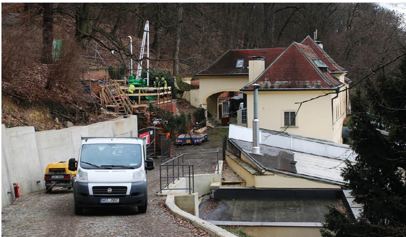
Obr. 1 Zařízení staveniště umístěné za restaurací Nebozízek na pražském Petříně
