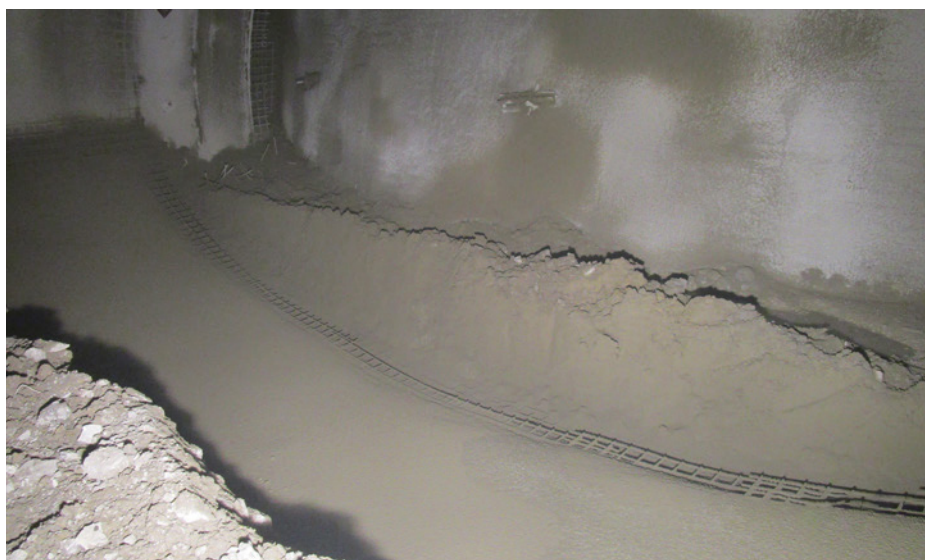
Obr. 12 Protiklenba budovaná v kalotě (falešné dno)
