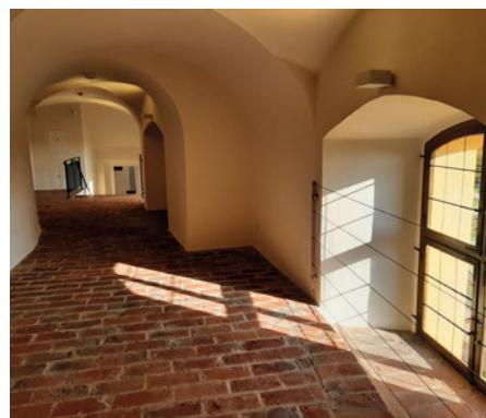
Obr. 12, 13 Pokládka cihelné dlažby chodeb
