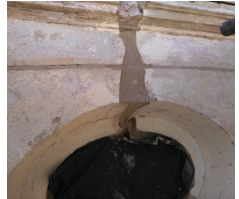
Obr. 3 Stabilizace trhlin sešitím pomocí helikální výztuže
