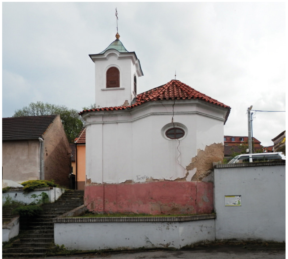
Obr. 6 Pohled na kapli před obnovou
