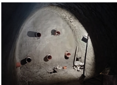
Obr. 17 Ukončení zrekonstruované štolý č. X železobetonovým čílkem v místě nebezpečného závalu
