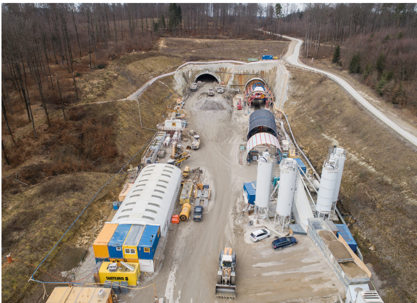
Obr. 1 Výstavba tunelu Herrschaftsbuck na dálnici A98 v SRN. Zařízení staveniště
