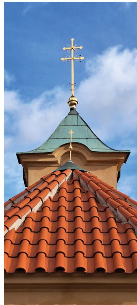
Obr. 13 Kaple sv. Máří Magdalény po obnově – pohled na zastřešení s křížovými hrotnicemi
