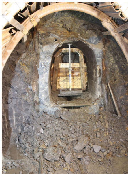
Obr. 11 Přeražba horní odvodňovací štoly č. X
