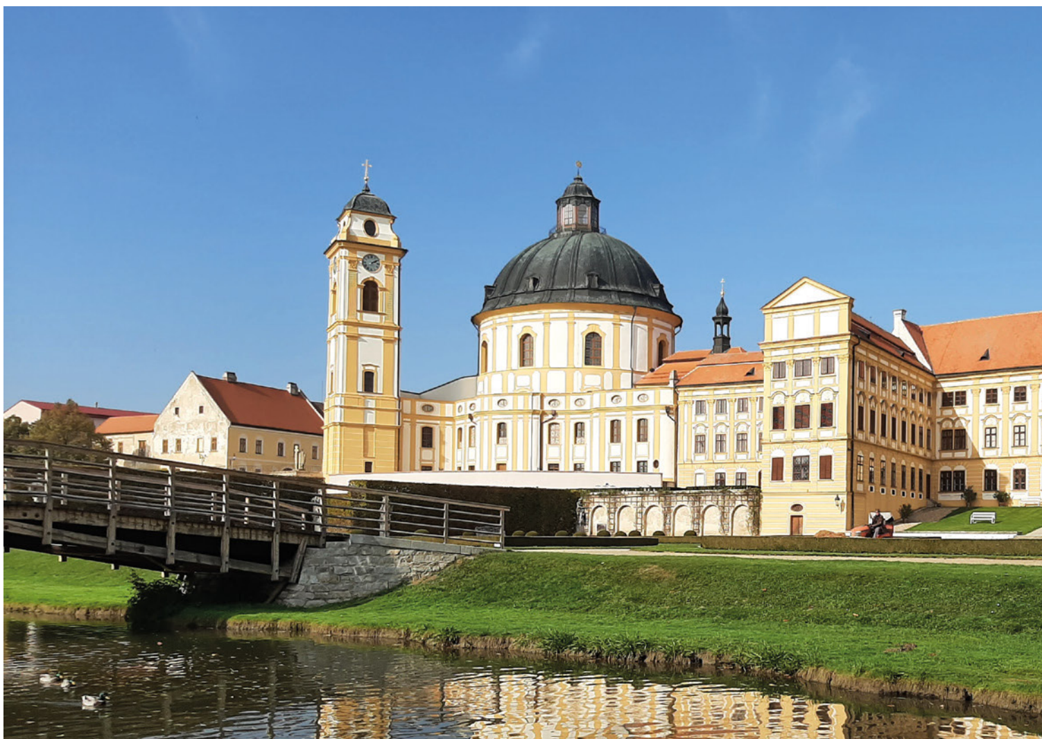
Obr. 1 Kostel sv. Markéty v Jaroměřicích nad Rokytnou, stav po obnově
