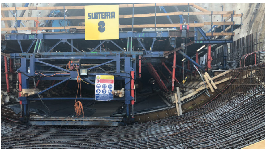
Obr. 18b Forma pro betonáž protiklenby
