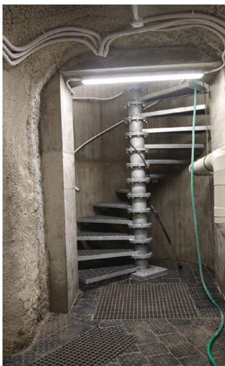
Obr. 12 Schodiště v těžní šachtě
