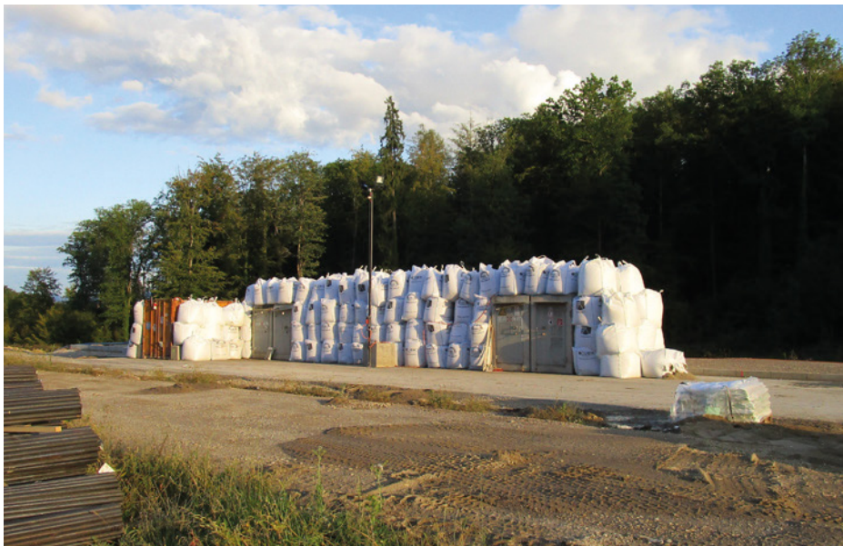
Obr. 4 Sklad trhavin před dokončením
