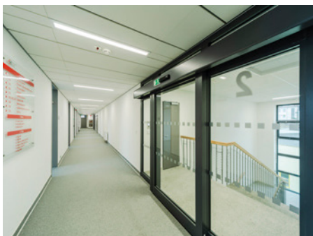
Obr. 3 Chodba ve 3. NP
