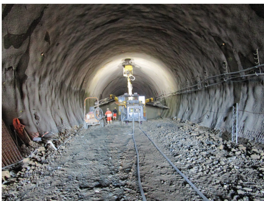
Obr. 13 Ražba lávky severní trouby
