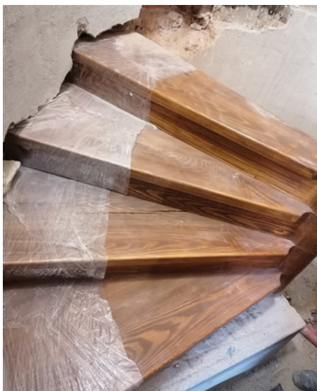
Obr. 10 Montáž a zazdívka dubového vřetenovitého schodiště
