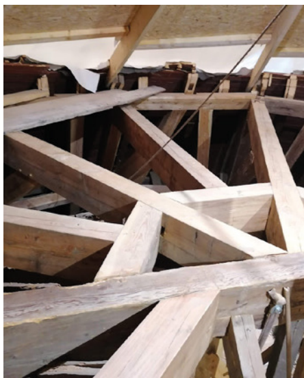
Obr. 11 Dokončená výměna rozpěrového patra vrcholu krovu
