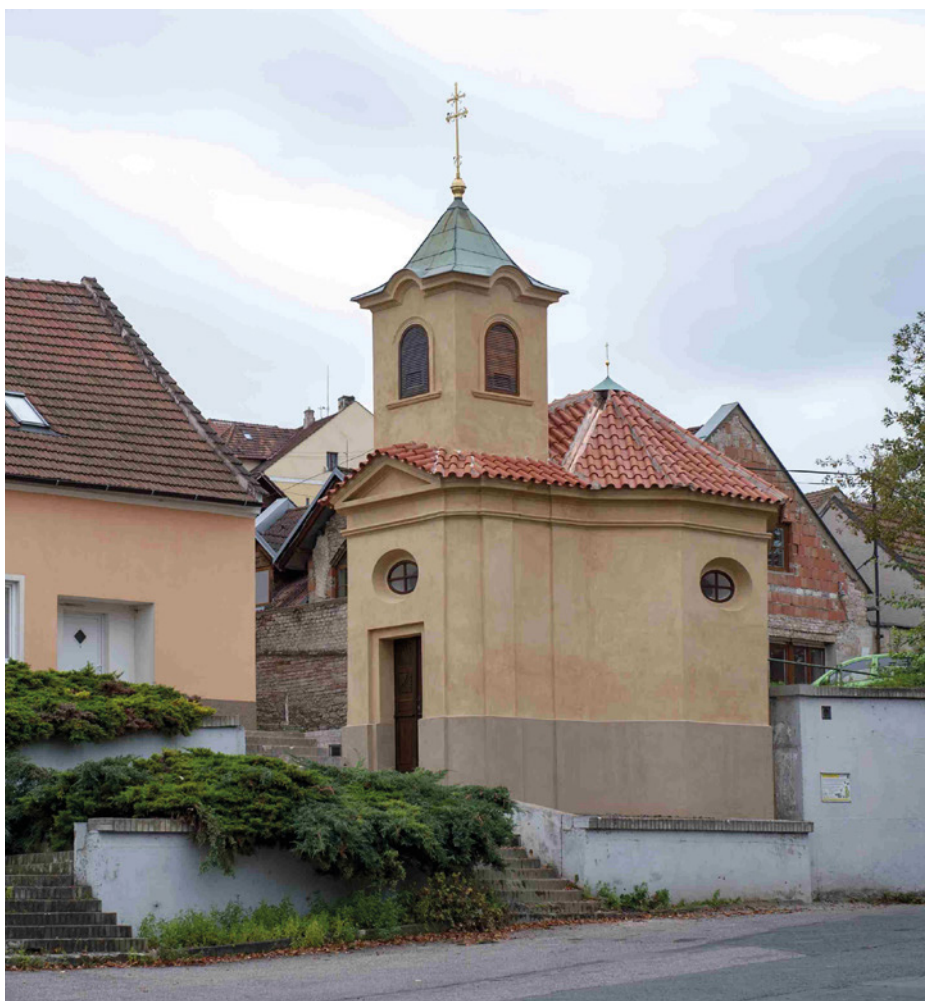
Obr. 12 Kaple sv. Máří Magdalény po obnově – severovýchodní pohled
