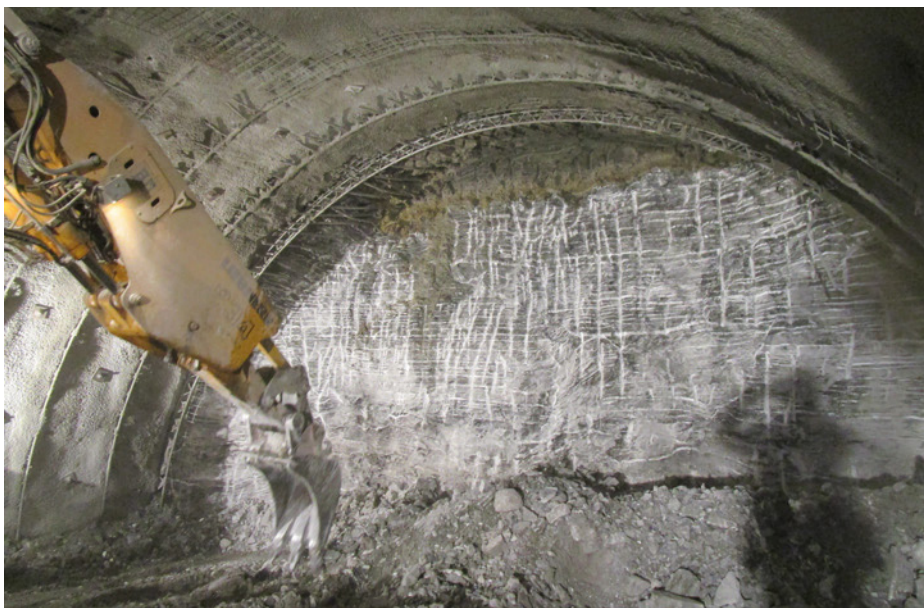
Obr. 9 Čelba kaloty – geologický profil (severní trouba)
