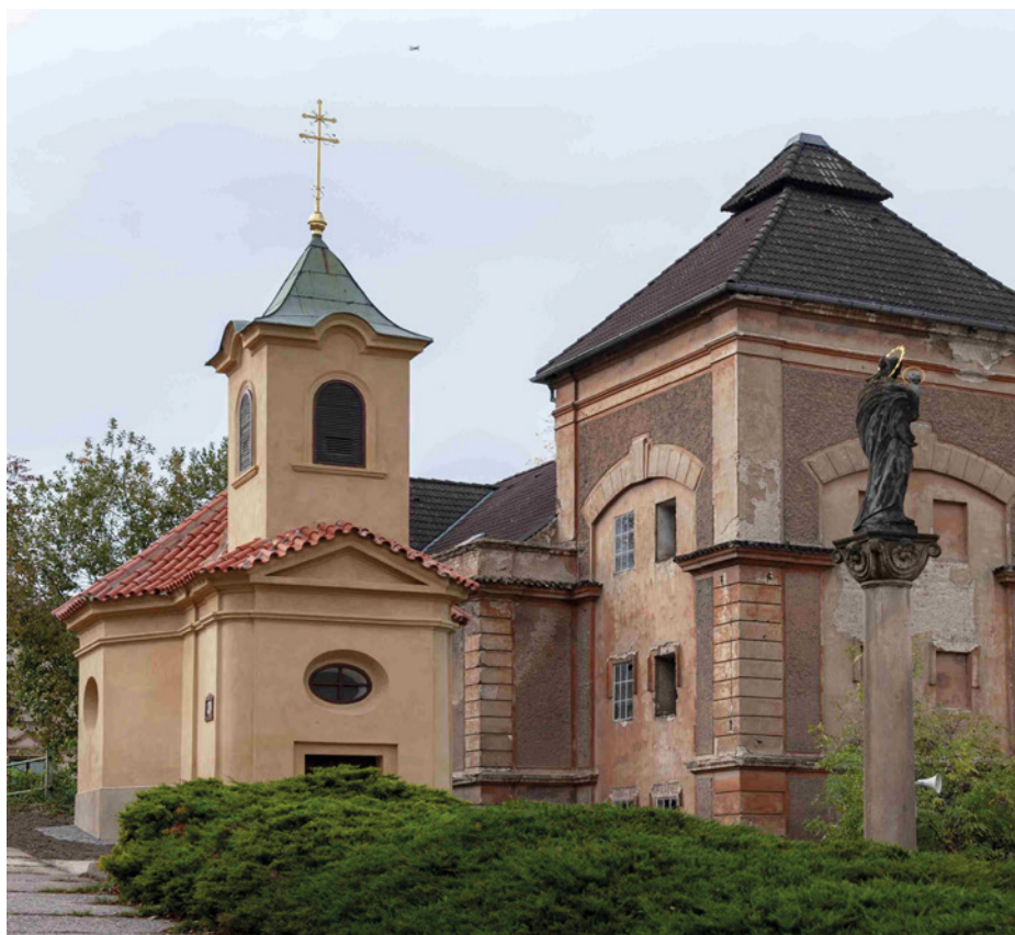
Obr. 1 Kaple sv. Máří Magdalény v Buštěhradě po obnově – jižní pohled
