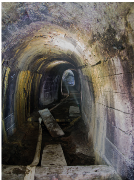
Obr. 10 Původní horní odvodňovací štola č. X
