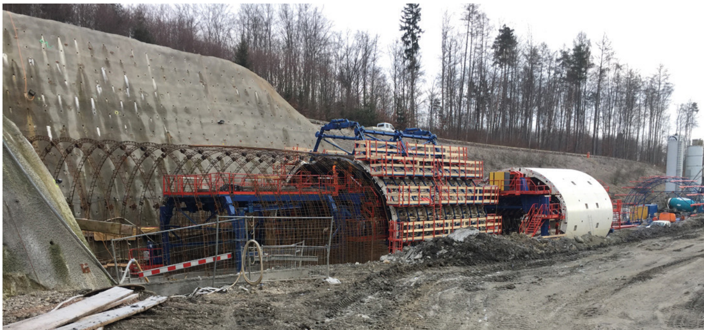
Obr. 17 Samonosná výztuž – hloubený úsek – severní trouba
