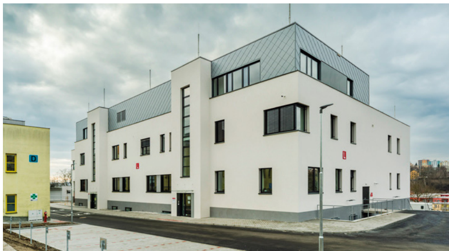
Obr. 1 Zrekonstruovaná budova transfúzního oddělení – pohled z jihovýchodu
