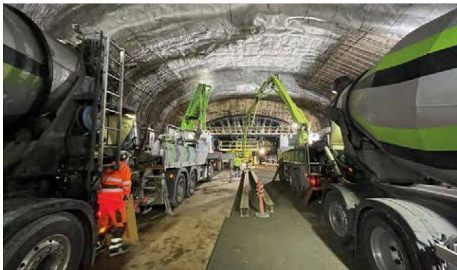
Obr. 12 Betonáž klenby ostění dvěma pumpami na čerpání betonu
