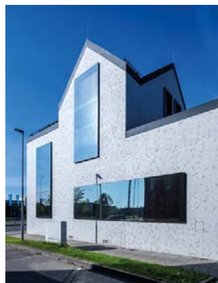
Obr. 2 Detail odhlučnění oken a fasády s použitím jemnozrné lakované omítky
