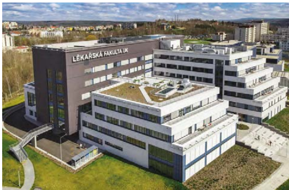
Obr. 3 Univerzitní medicínské centrum Lékařské fakulty Univerzity Karlovy UniMec II, pohled z jihozápadu. Vpravo je patrný jižní vstup do budovy a posedové schody
