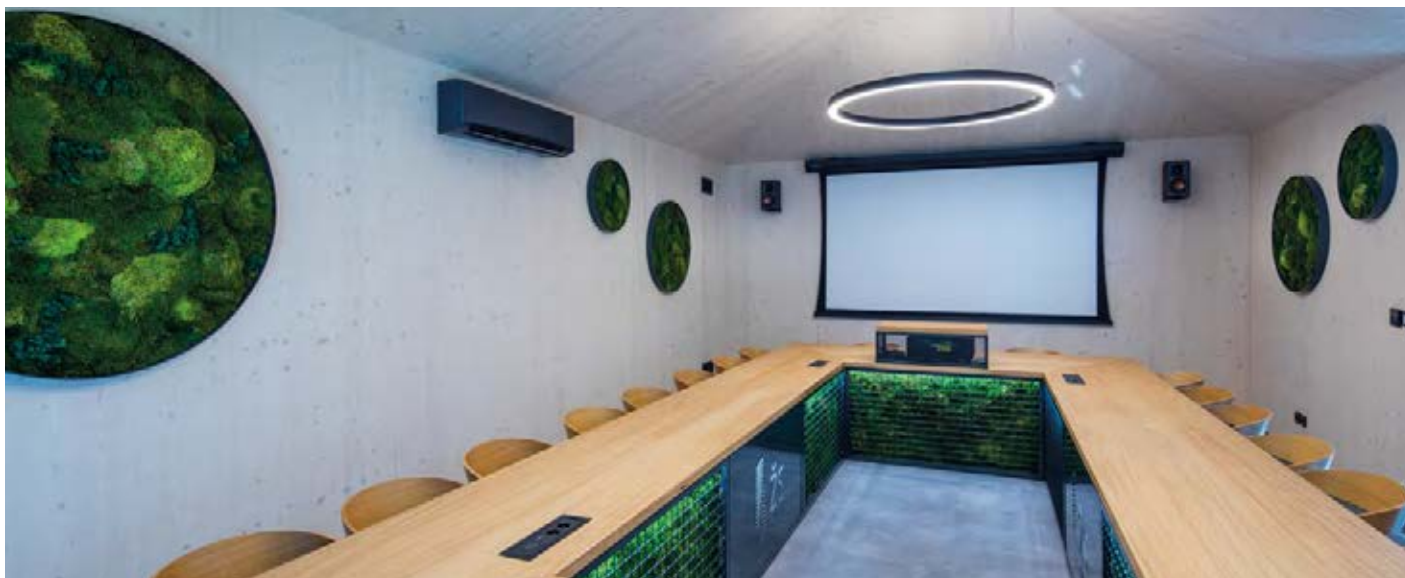
Obr. 4 Nová zasedací místnost v přístavbě s použitím masivních CLT panelů
