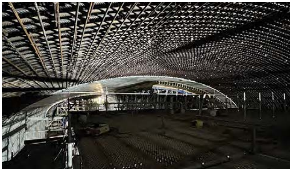
Obr. 9 Armokoš výztuže před posunem bednění
