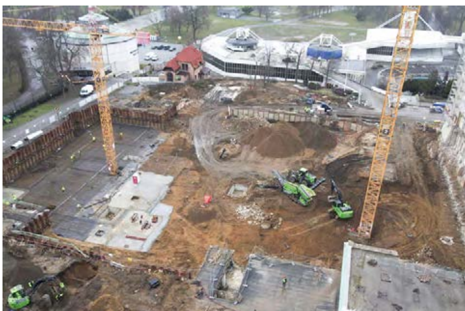
Obr. 4 Zajištění stavební jámy levého křídla paláce
