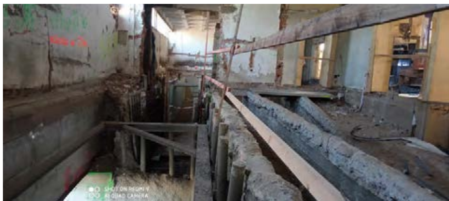
Obr. 8 Instalační kanály uvnitř boční lodi, vlevo nový kolektor zajištěný tryskovou injektáží, vpravo původní instalační kanály
