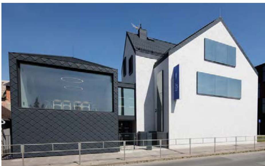
Obr. 1 Pohled z jižní strany na přístavbu a revitalizovaný objekt
