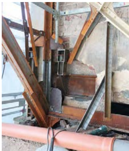
Obr. 12 Stav styčnicku během sanace (foto: Excon a.s.)
