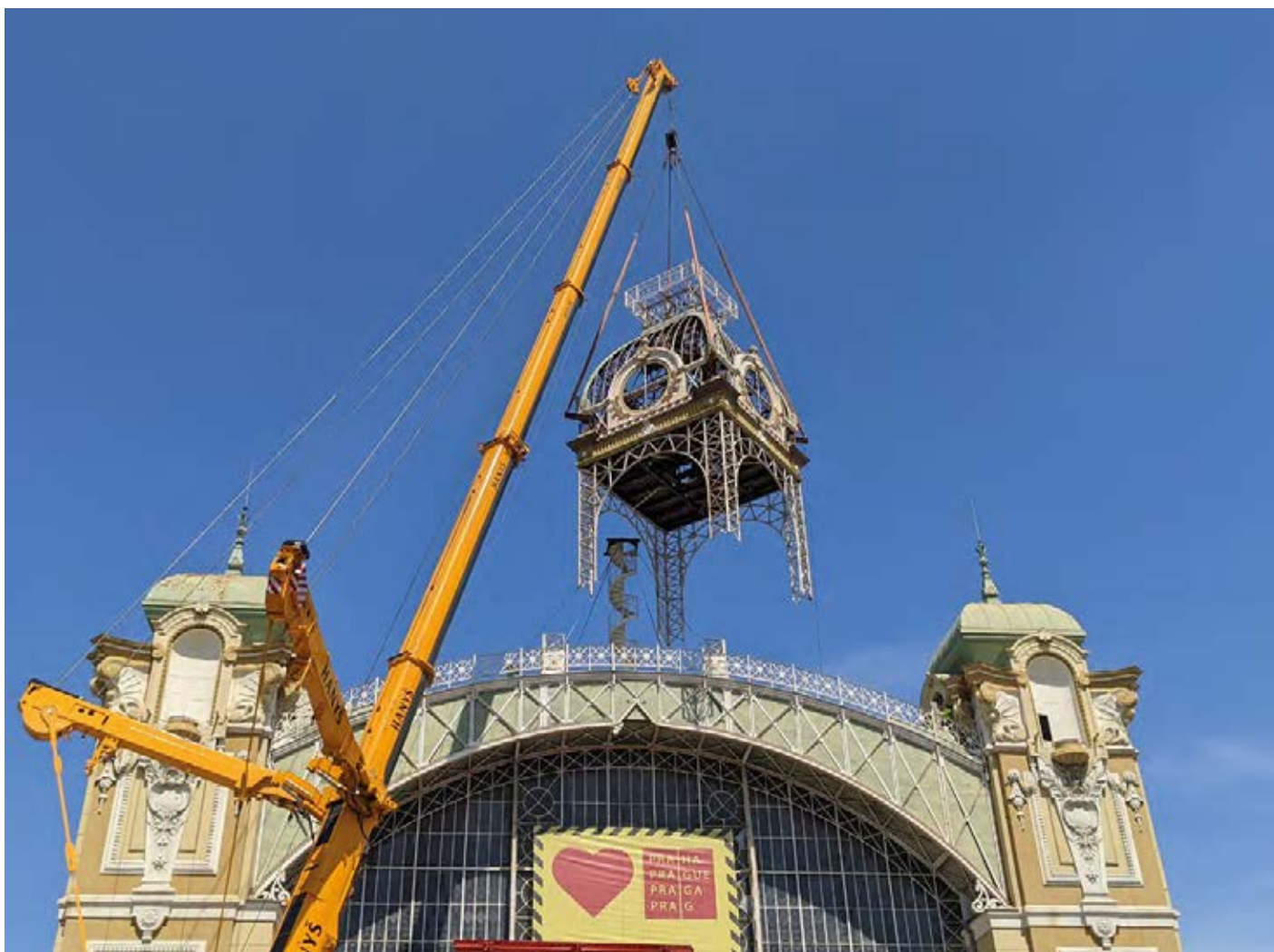
Obr. 13 Demontáž hodinové věže (foto: Jiří Šebek, Výstaviště Praha)
