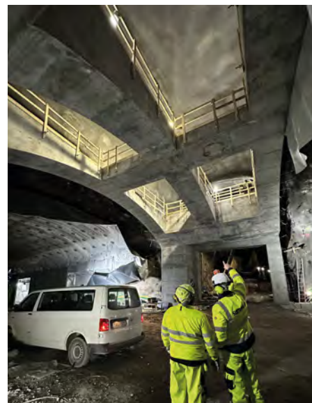
Obr. 15 Vybetonovaný objekt odvodu spalin
