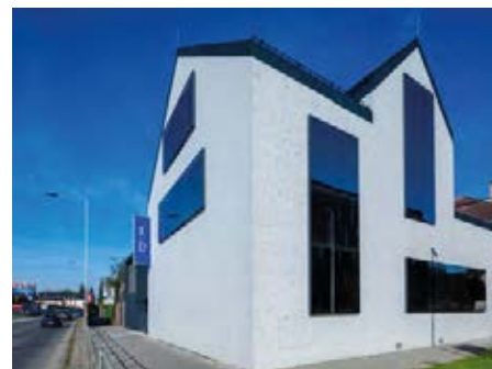
Obr. 3 Revitalizovaný objekt – východní pohled z ulice Tovární
