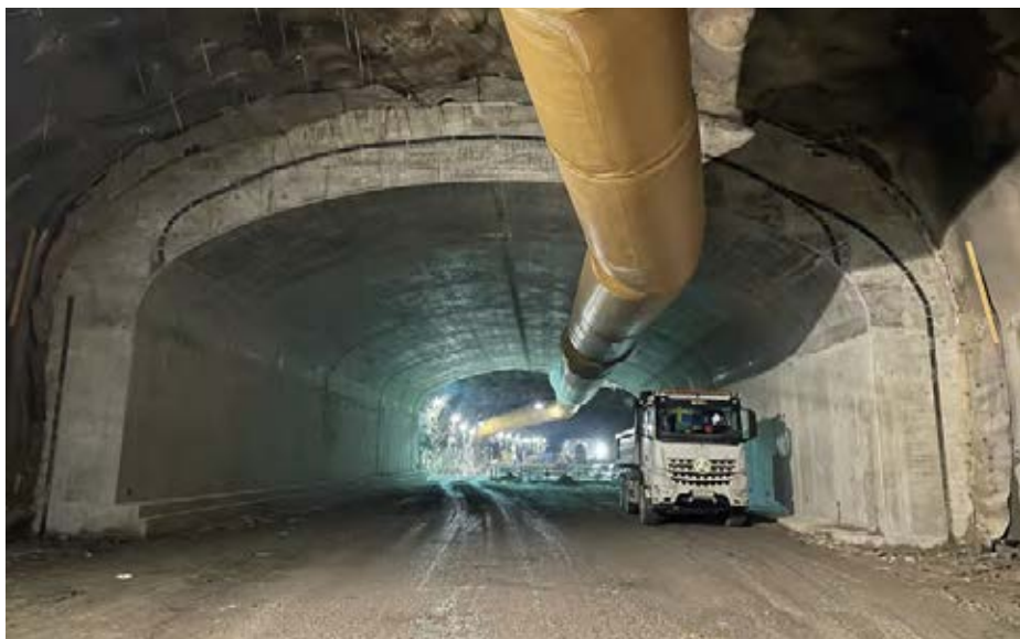
Obr. 14 Dokončené sekundární ostění tunelové trouby HT202
