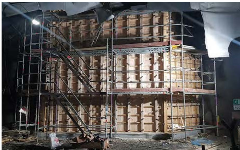
Obr. 18 Příklad tradičního tesařsky provedeného bednění tvarově zalomené stěny propojky
