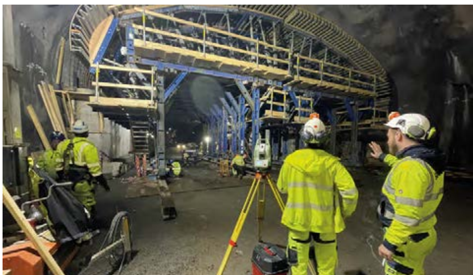
Obr. 7 Bednění horní klenby ostění
