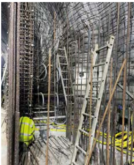
Obr. 11 Upevnění potrubí systému chlazení k výztuži stěny ostění
