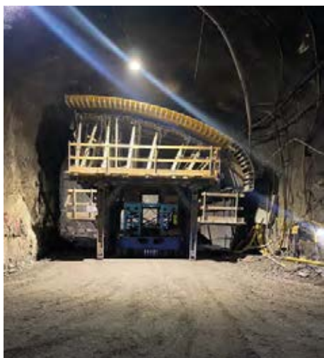
Obr. 8 Speciální samohybný podvozek pro transport bednění klenby
