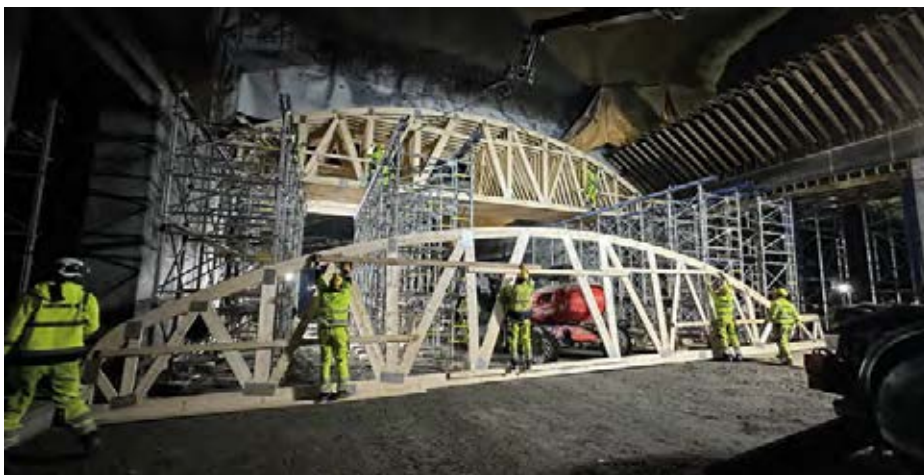
Obr. 16 Dřevěné vazníky bednění klenby objektu odvodu spalin
