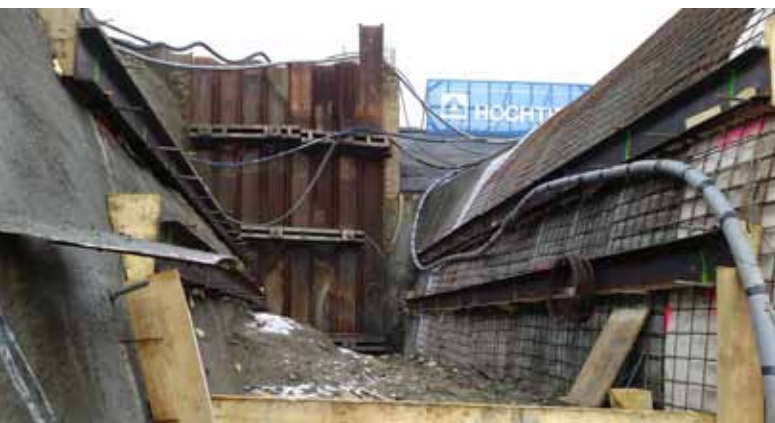
▲ Obr. 12. Zásyp a prvky rozepření před betonáží definitivního ostění
