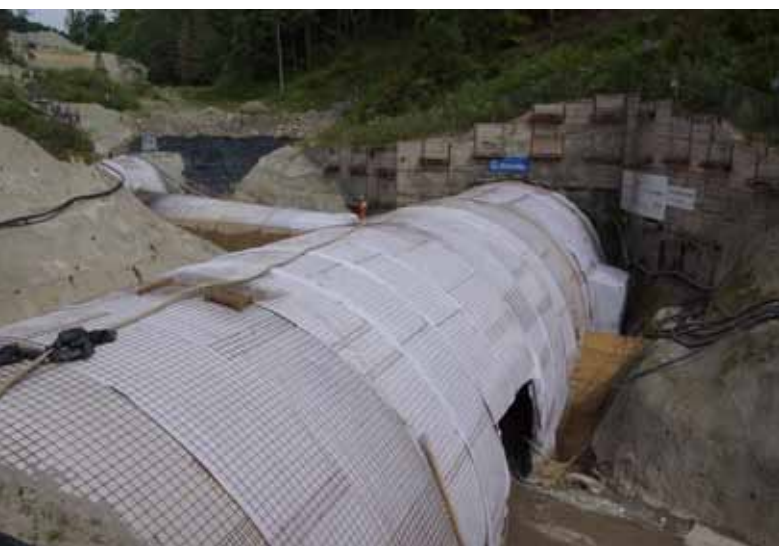
▲ Obr. 6. Délka hloubeného úseku jižní trouby ve střední stavební jámě
