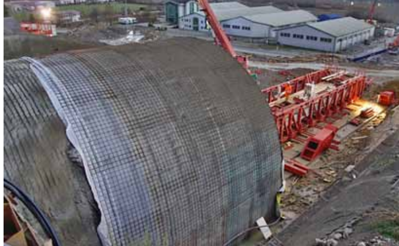
▲ Obr. 11. Falešné primární ostění na západním portále tunelu
