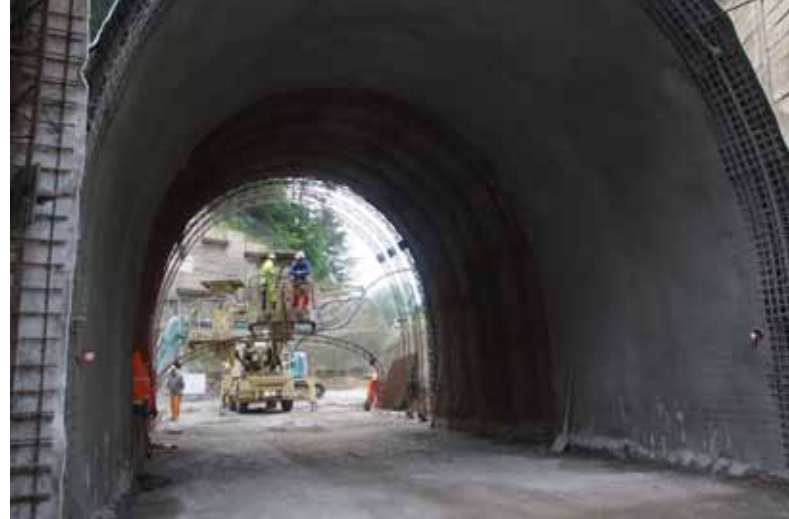
▲ Obr. 9. Líc falešného primárneho ostění po dostřikání betonu
