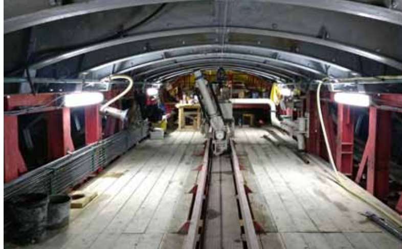
▲ Obr. 17. Mezistrop bednicího vozu s rozdělovačem betonové směsi
