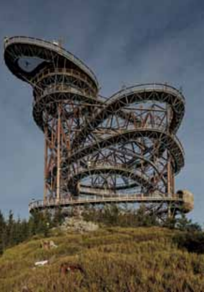
▲ Stezka v oblacích; Dolní Morava; autor: Zdeněk Fránek ARCHITECT & ASSOCIATES s.r.o.; investor: SNĚŽNÍK, a.s.; dodavatel: TAROS NOVA s.r.o.
