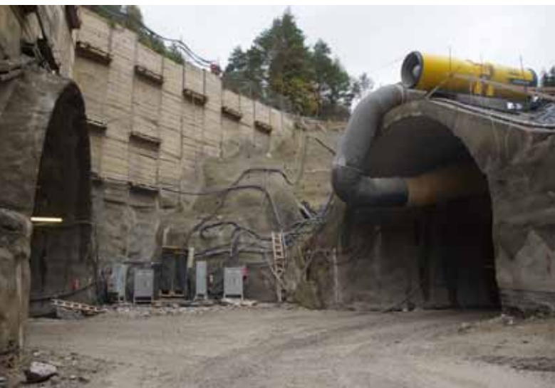
▲ Obr. 5. Vzdálenost portálů severní trouby ve střední stavební jámě
