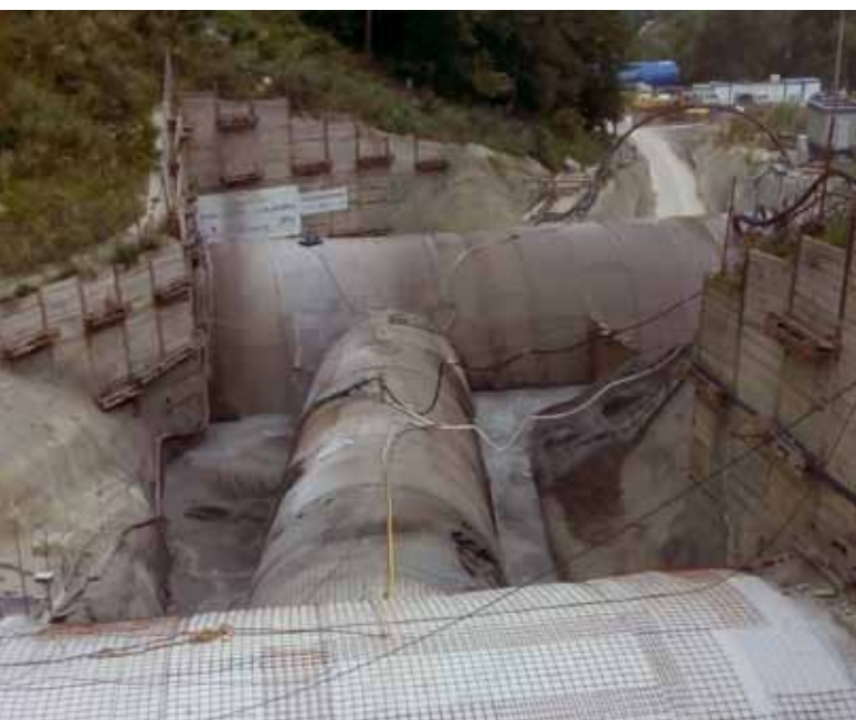
▼ Obr. 14. První fáze zaplavování střední jámy popilkem
