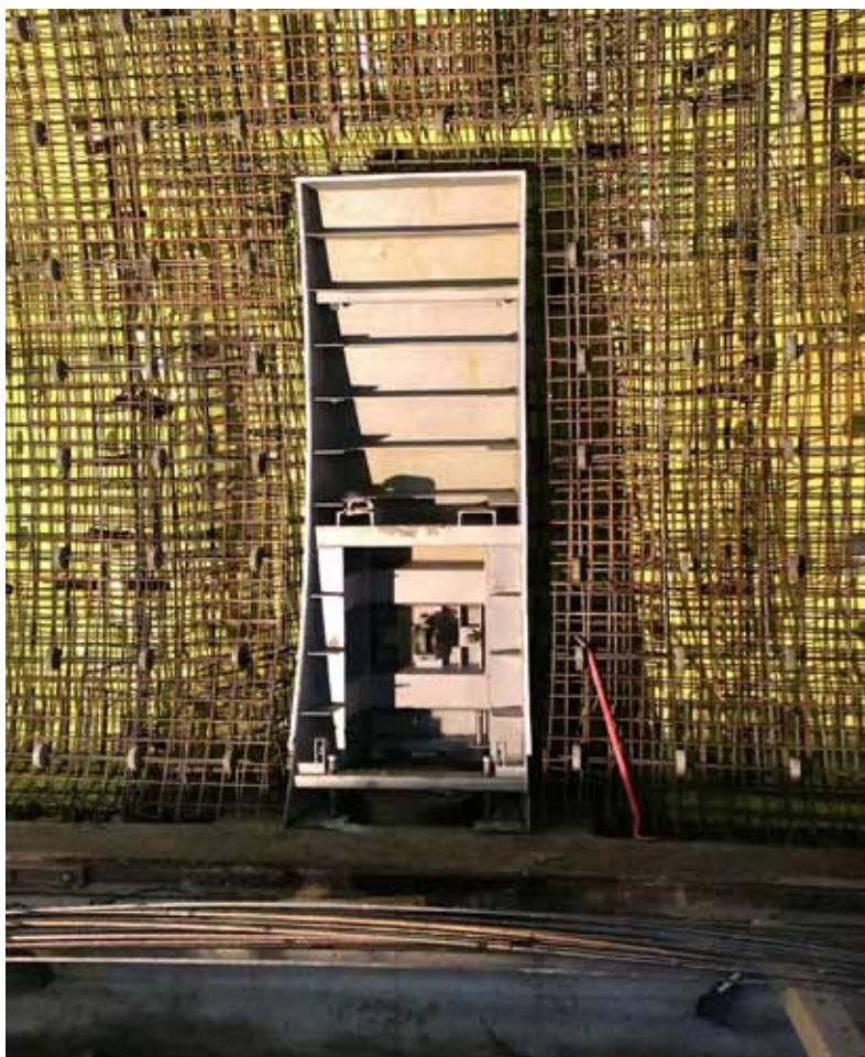
▲ Obr. 18. Bednění výklenku šachty na čištění tunelové drenáže
