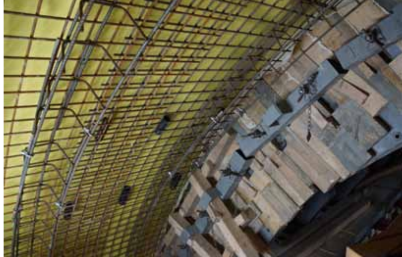
▲ Obr. 20. Bednění čela bloku betonáže a spojování výztužných rámu
