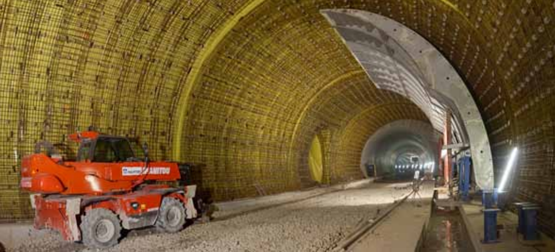
▲ Obr. 19. Samonosná výztuž a bednění nouzového závalu
