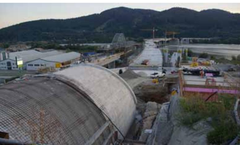
▲ Obr. 23. Portál tunelu a návaznost na estakádu přes Hričovskou vodní nádrž
