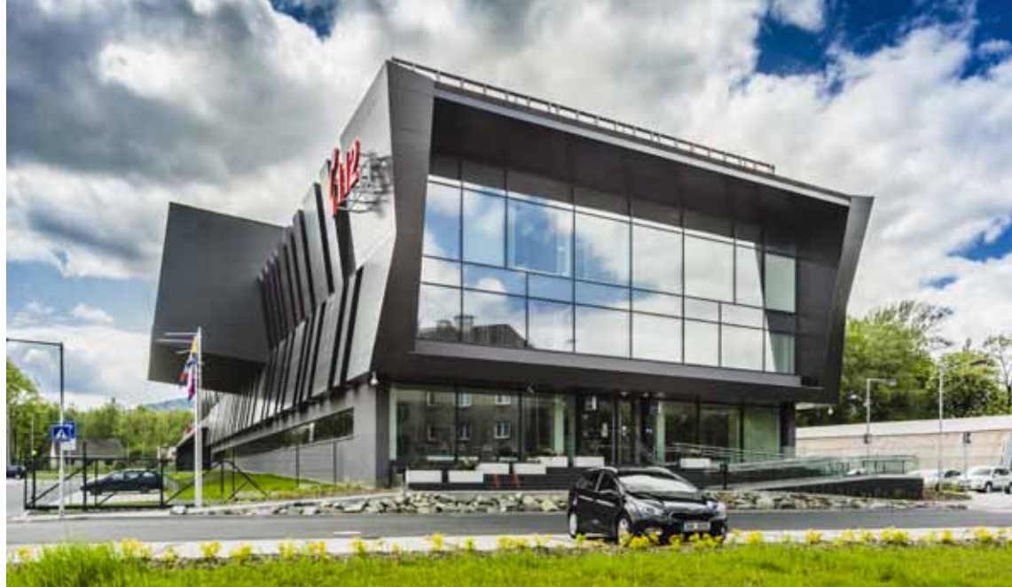
▲ Pohled na severní průčelí budovy
