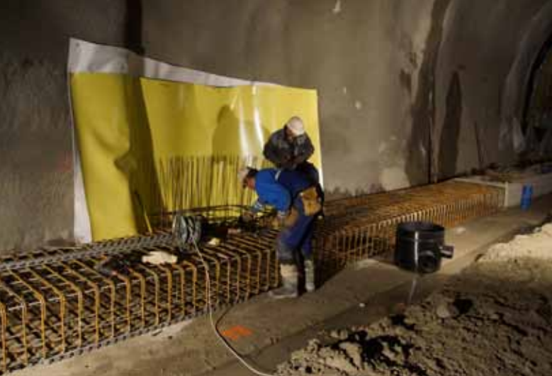
▲ Obr. 4. Vyztužení základových pasů tunelového ostění
