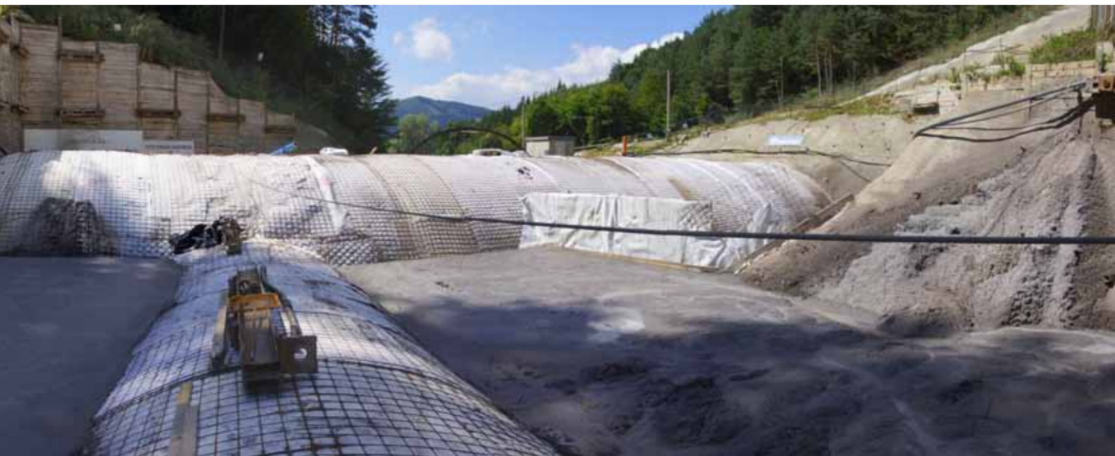
▲ Obr. 18. Bednění výklenku šachty na čištění tunelové drenáže
