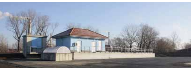
▲ Přerov – výstavba levobřežního a pravobřežního sběrače s napojením Dluhonic a Kozlovic; autor: AQUATIS a.s.; investor: Vodovody a kanalizace Přerov, a.s.; dodavatel: OHL ŽS, a.s.
