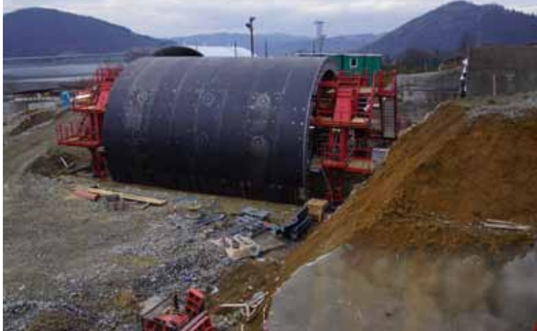
▲ Obr. 16. Montáž bednicího vozu na západním portále tunelu
