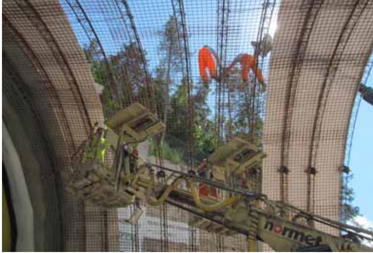
▲ Obr. 7. Montáž výztuže falešného primárneho ostění
