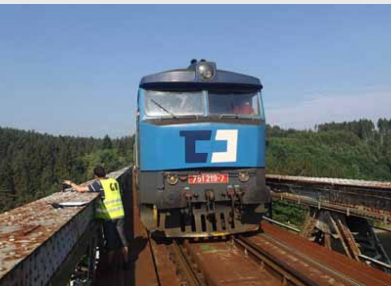
▲ Obr. 5. Lokomotiva řady 751 (HV751) během statické zatěžovací zkoušky
