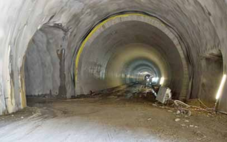
▲ Obr. 10. Falešné primární ostění v místě napojení tunelové propojky
