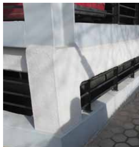
▲ Použití protipožární omítky Sibaterm v exteriéru
