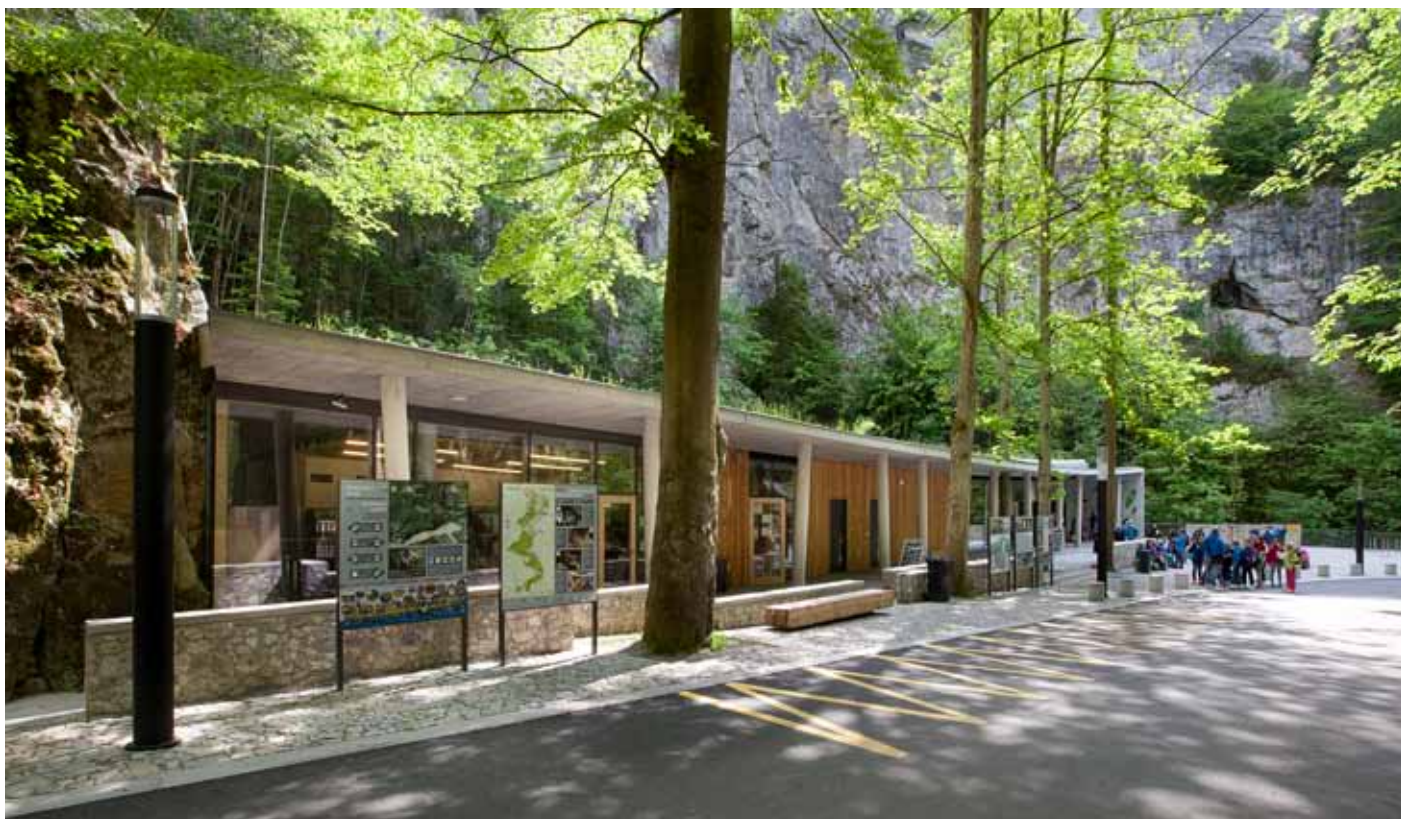
▲ Subtilní betonová střeška s travním porostem chrání stavbu před padajícími kameny
