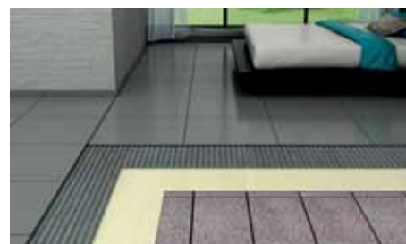
▲ Dlažba na dlažbu
