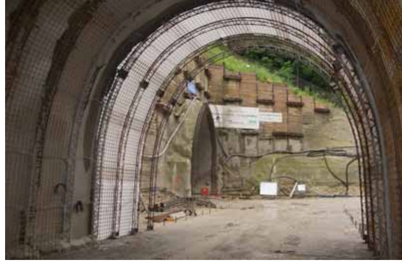
▲ Obr. 8. První nástřik betonu falešného primárneho ostění
