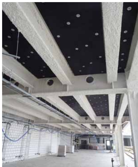
▲ Bezproblémová ochrana i tvarově složitějších konstrukcí. Letiště Polsko
